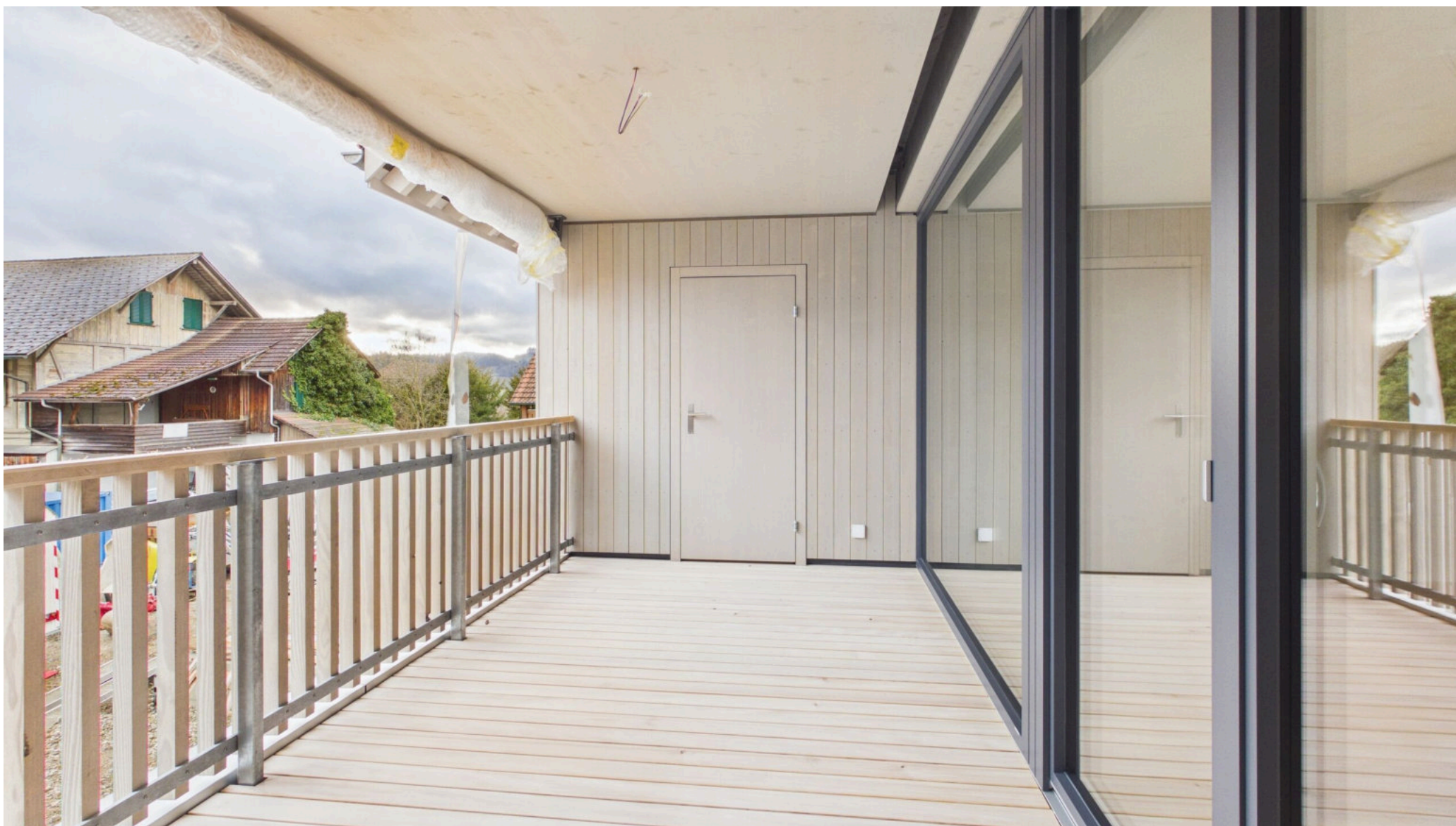
Terrasse OG mit Reduit (Feb. 2026)
